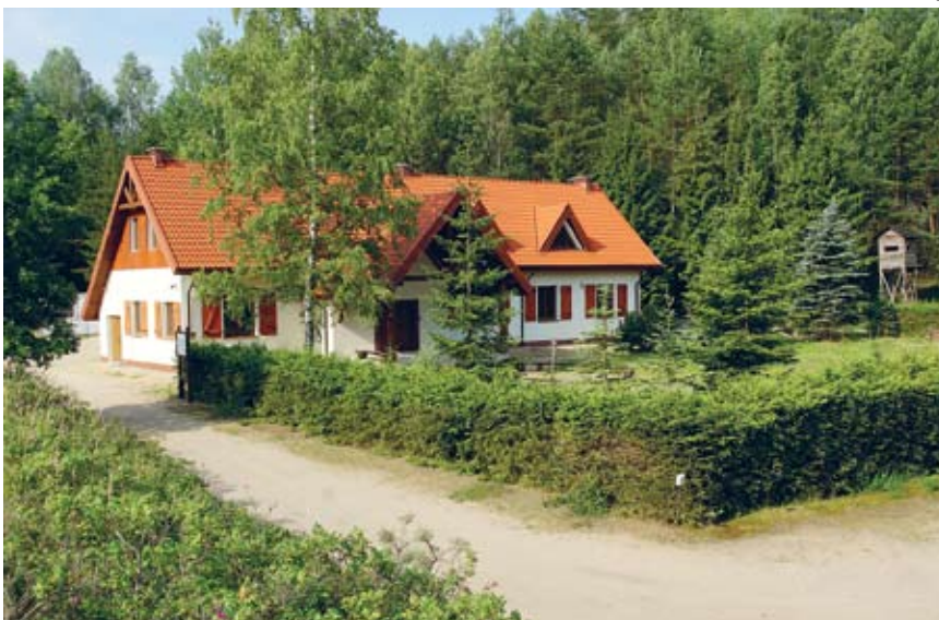
Budynek na terenie W-MCEE w Olsztynie/Gutkowie)
