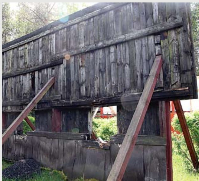
Ściana przed remontem
