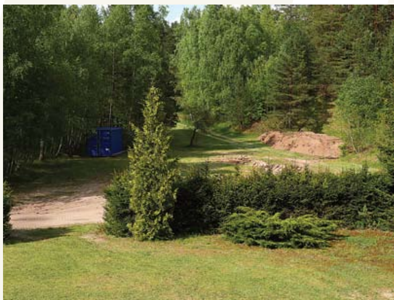
Osł do strzelania z broni krótkiej w budowie
